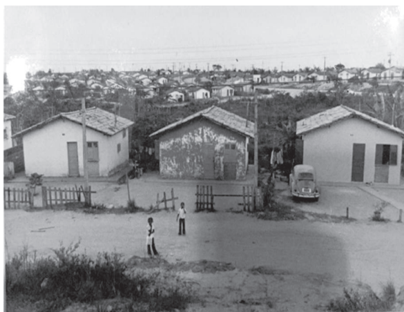
Figura - 3. Uso de material de baixa no acabamento das casas de Castelo Branco – 1983
